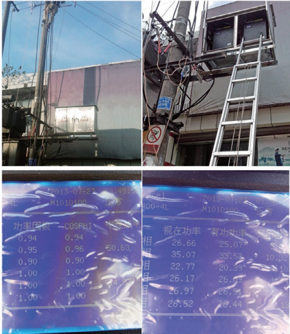
海口市 CCD 某试点，现场安装效果
